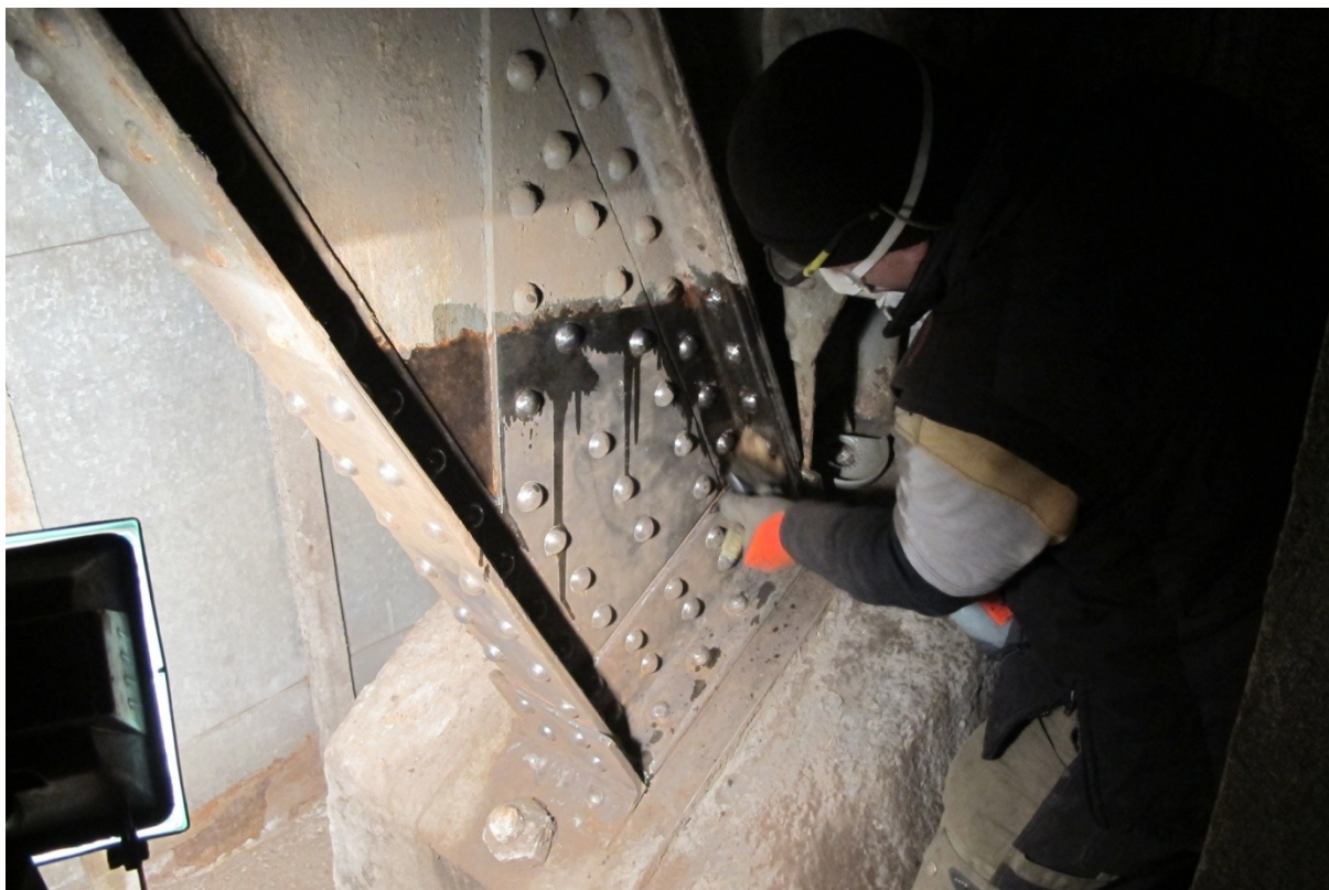
Vtírání odrezovače do povrchu.
