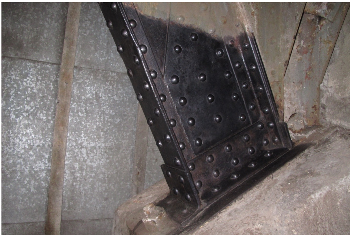
Navoskovaný a zaleštěný povrch.
