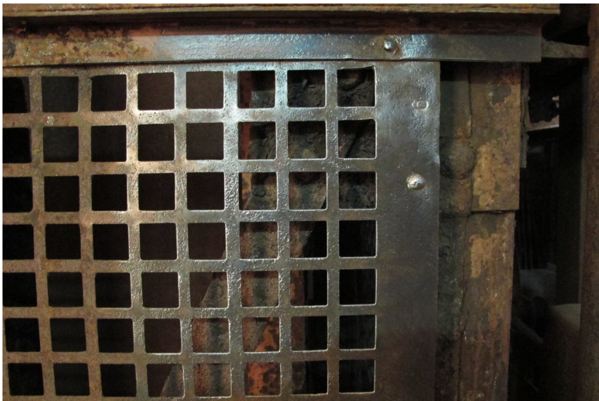
Mechanické očištění rzi ocelovými kartáči.
